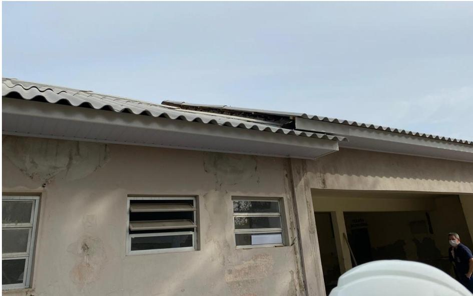
**Figura 27:** Diferença de nível no telhado a ser coberta. (Fonte: Dos Autores 2020).
