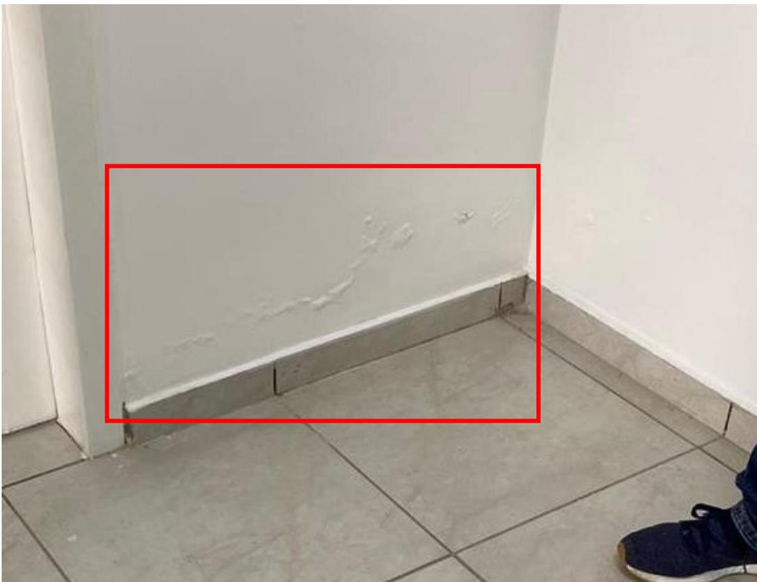
**Figura 16:** Infiltração a ser reparada. (Fonte: Dos Autores 2020).
