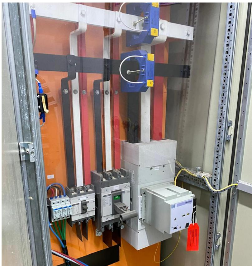
**Figura 30:** Distribuidor de energia. (Fonte: Dos Autores 2020).
