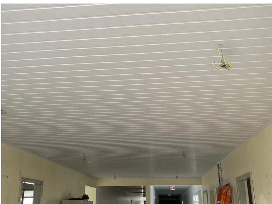
**Figura 24:** Forro recolocado. (Fonte: Dos Autores 2020).
