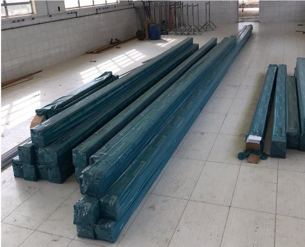
**Figura 7:** Materiais armazenados corretamente. (Fonte: Dos Autores 2020).
