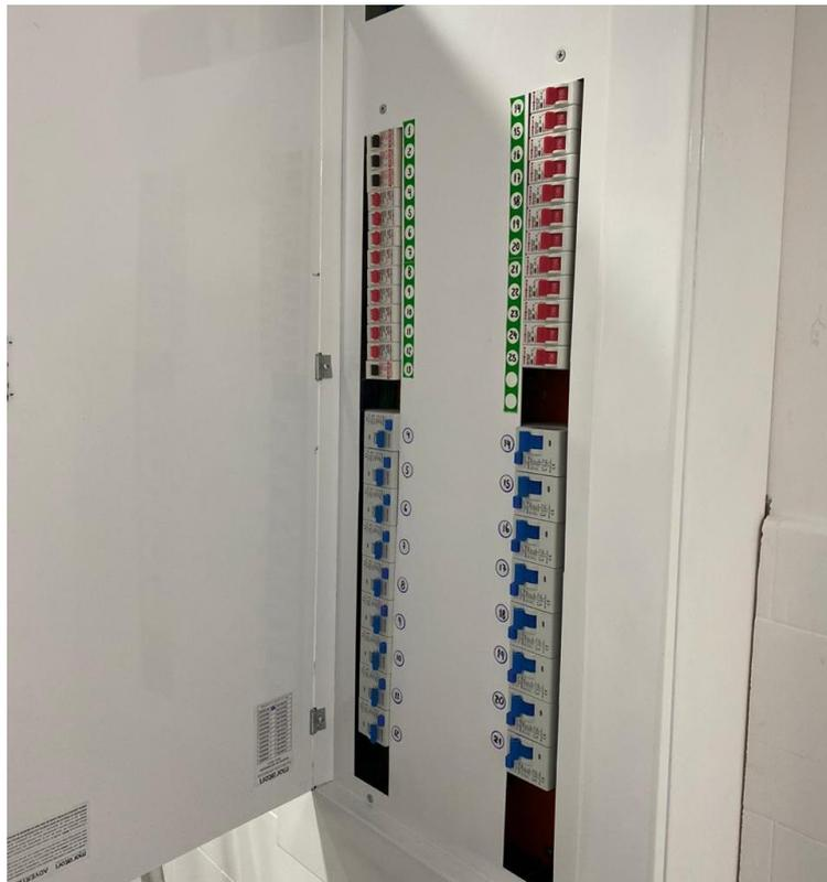
**Figura 19:** Central de disjuntores. (Fonte: Dos Autores 2020).
