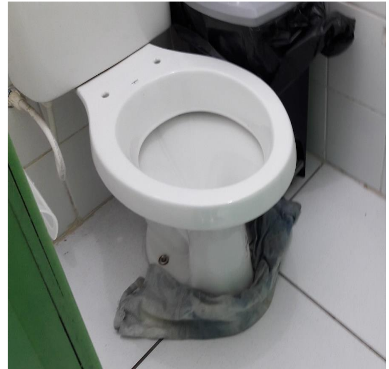
Banheiro com vazamento de água.
