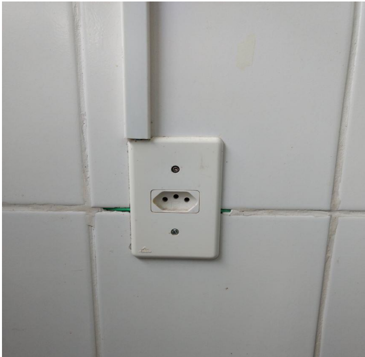
Falta de tubulação na fiação elétrica.
