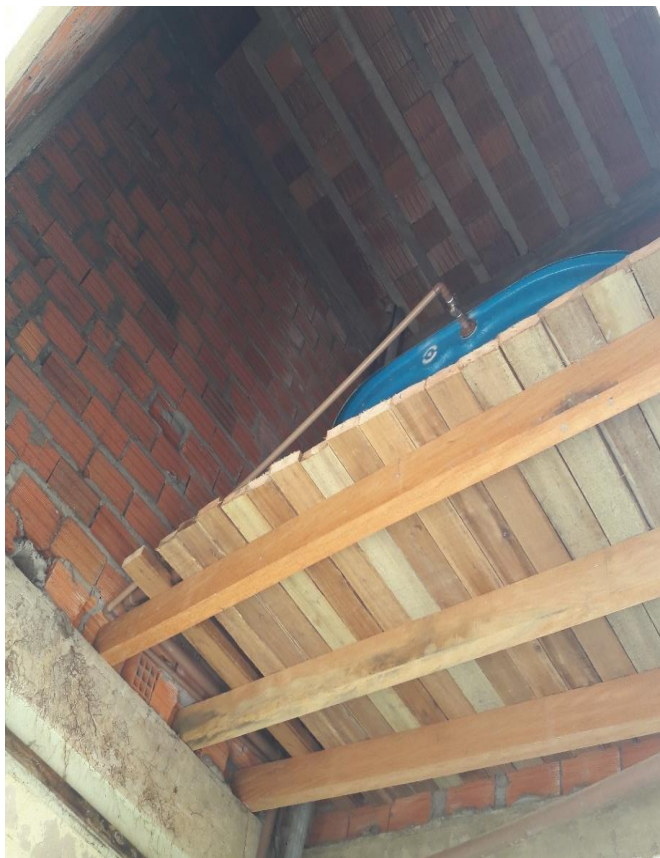
Caixa d'água provisória.
