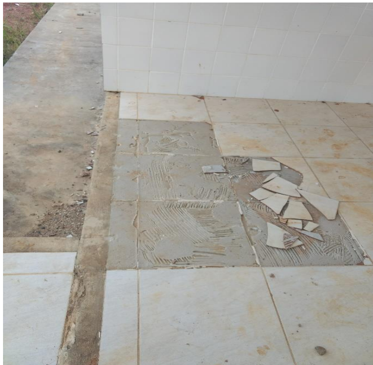
Pisos da área de lazer e banheiro quebrados.
