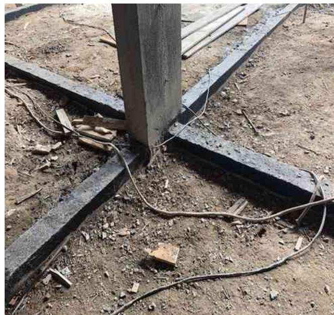
**Conclusão 10<sup>a</sup> a 12<sup>a</sup> Visita:** A ausência de impermeabilização foi corrigida. Na desforma pode-se perceber a retirada da parte do enchimento da viga (V-330), a qual, possivelmente, está com a resistência reduzida, podendo colocar a estrutura em risco ao longo do tempo. Foi contatado o engenheiro responsável, o qual informou que será feito o reparo.
