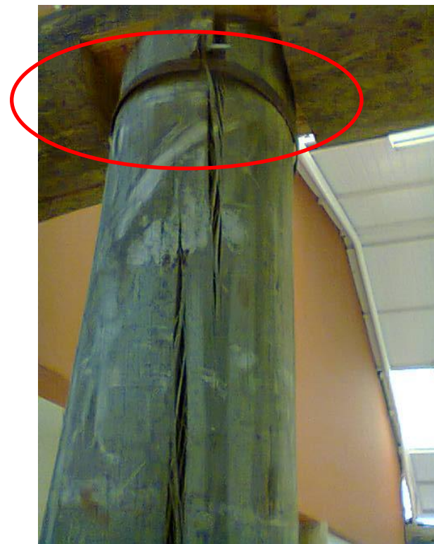
Inconformidade 4: Eucaliptos apresentando Rachaduras.
