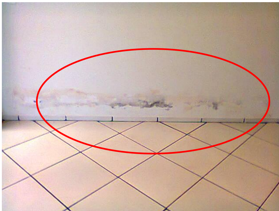
Inconformidade 3: Infiltrações.
